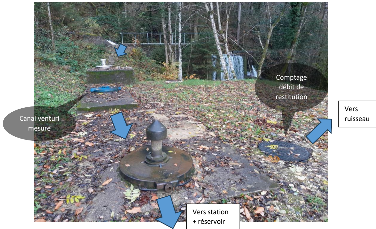
Figure 9 Vue du captage de la Roche-Saint-Alban depuis les réservoirs.
